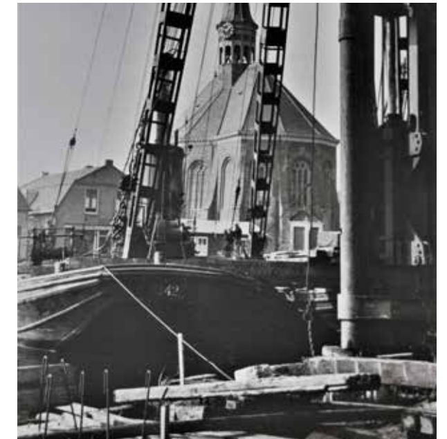
Zicht van de nieuwe brug in aanbouw op de kerk.
