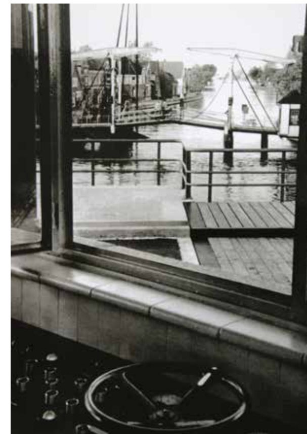
Het uitzicht van de brugwachter vanuit zijn huisje op de nieuwe brug.
