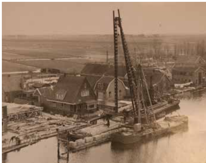
Heistelling op ponton aan de wetering
